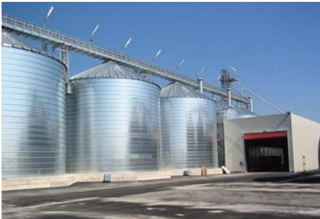
▲ La continua ventilazione e movimentazione della massa stoccata permette di evitare che si formi un pericoloso "cappello" nella parte alta dei silos.
